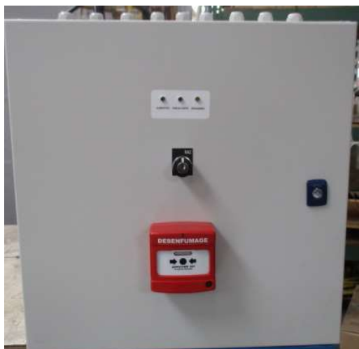
Vue extérieure du dispositif de commande avec bouton de réarmement et organe de déclenchement manuel
